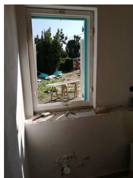
New door frame
